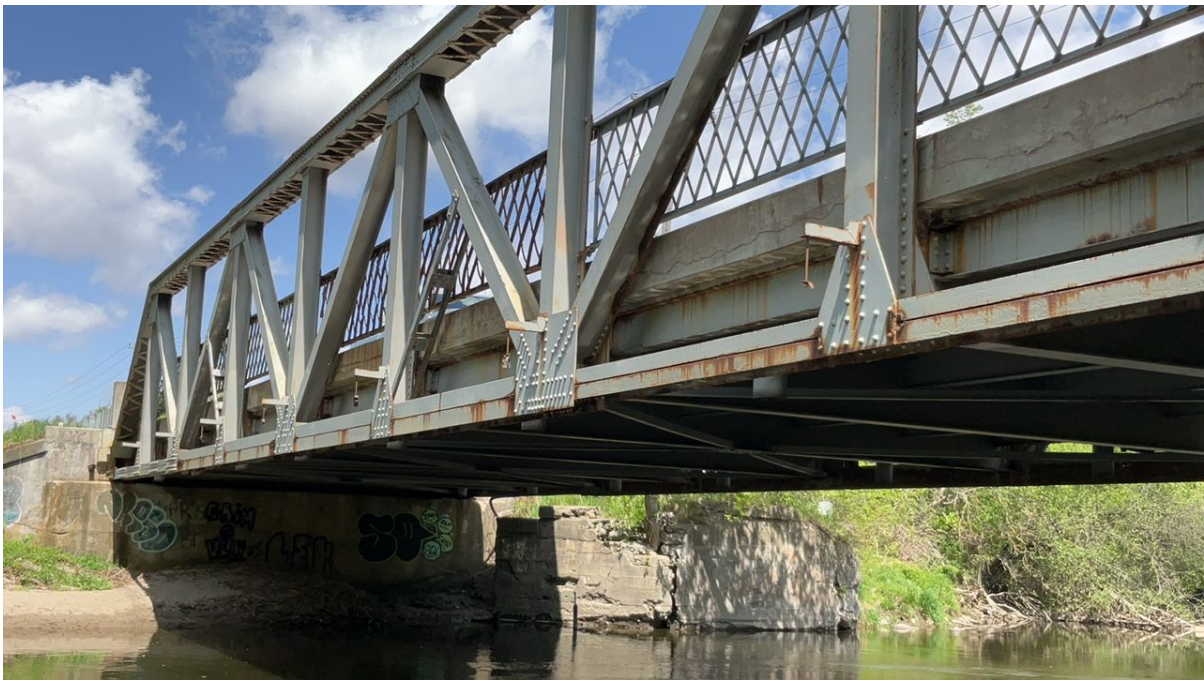
West exterior soffit.
